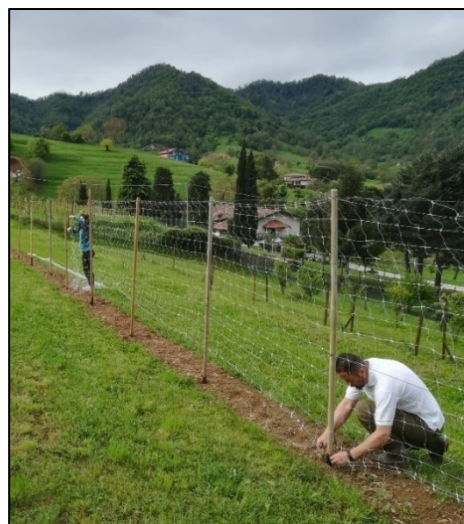
Figura 20: Posizionamento rete sui pali presso: La fattoria di Martina (C).
